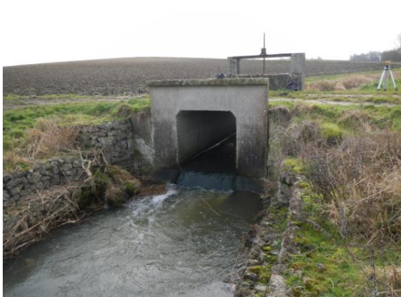
Photo 10 - Exemple d'aménagement pour compenser une chute – pont sur la petite Rimarde
