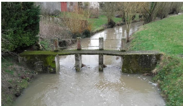
Ouvrage de Courcelles amont à effacer
