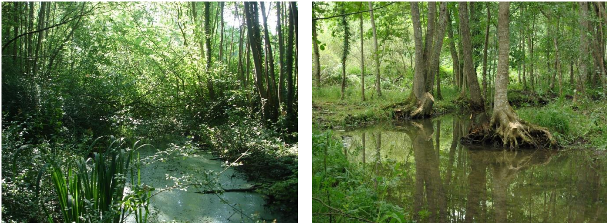
Photo 5 - Exemple de noue fermée par la végétation et après restauration
