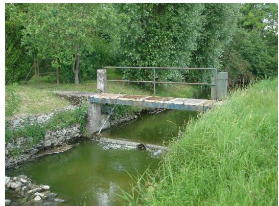
Ouvrage de Courcelles aval à effacer
