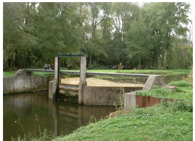
Ouvrage de Bouville à supprimer
