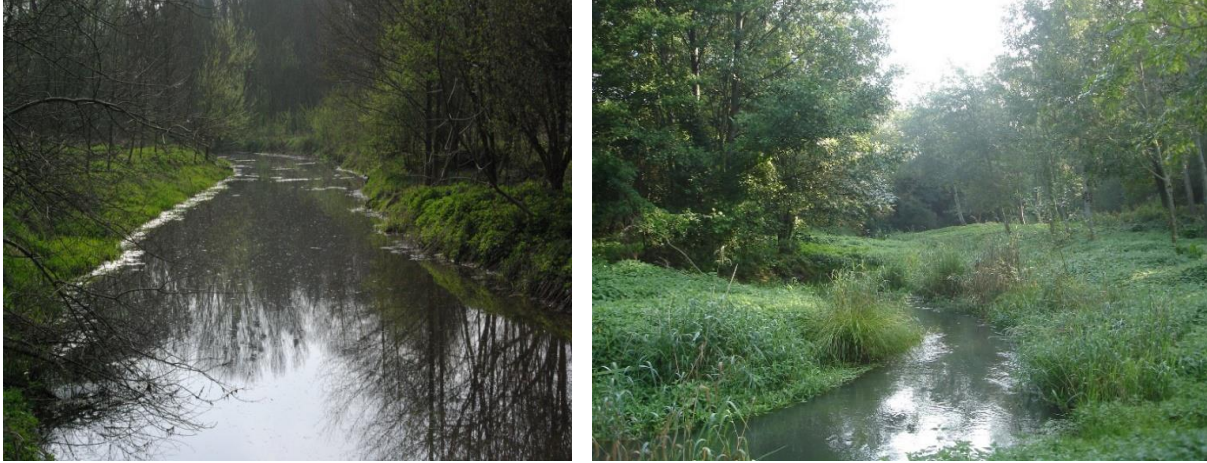
Photo 4 - Reméandrage de l'Œuf par talutage des berges (photo avant et après travaux)
