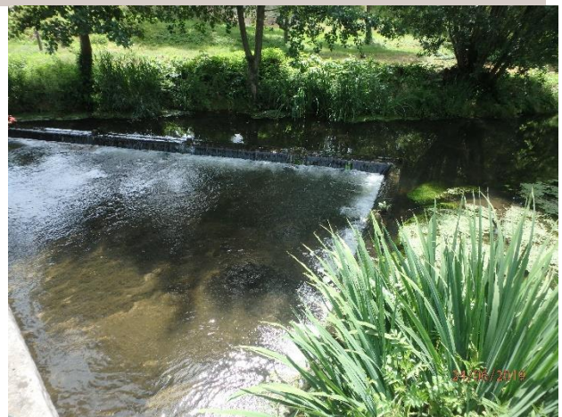
Seuil en « V » de la Porte à supprimer
