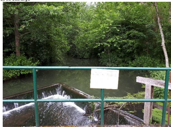
Seuil en « V » de Doureux à supprimer
