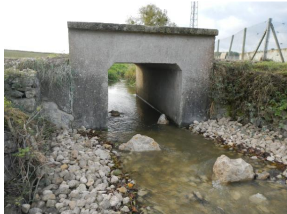
Photo 10 - Exemple d'aménagement pour compenser une chute – pont sur la petite Rimarde
