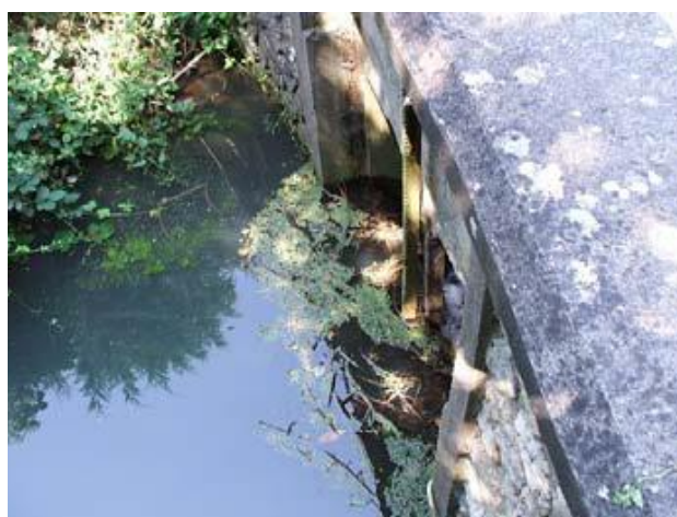
Ouvrage sur la Rimarde à effacer
