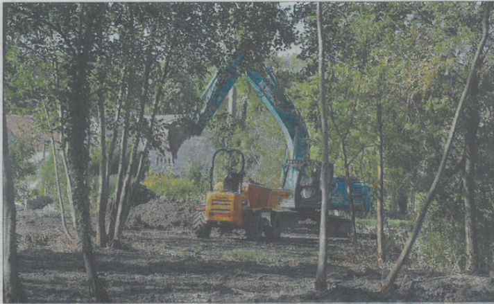
Les travaux ont été confiés à une entreprise spécialisée dans les ouvrages et travaux liés à la protection de l'environnement en zones humides.
