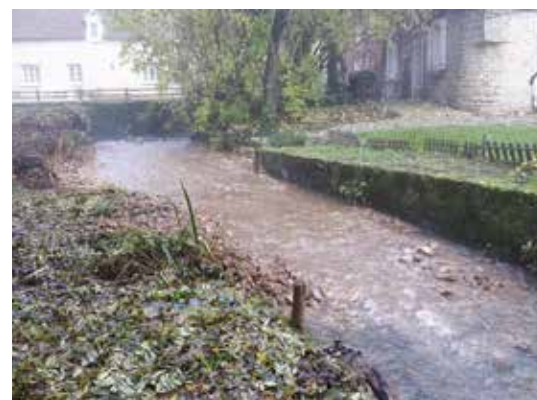
Bras de décharge du Moulin de Doureux rendu franchissable
