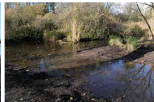
Création d'échancrures dans la berge pour restaurer la fonctionnalité hydraulique de la zone humide
