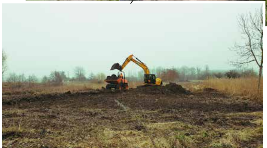
Talutage des berges en pente douce pour diversifier les milieux et augmenter la surface d'écrêtage de crues
