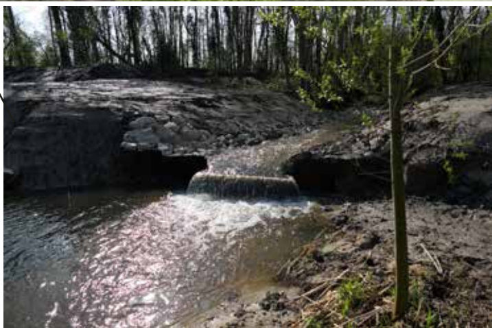
Barrière à écrevisses installée à l'amont du site pour sécuriser le réservoir de biodiversité de la population d' Austropotamobius pallipes
