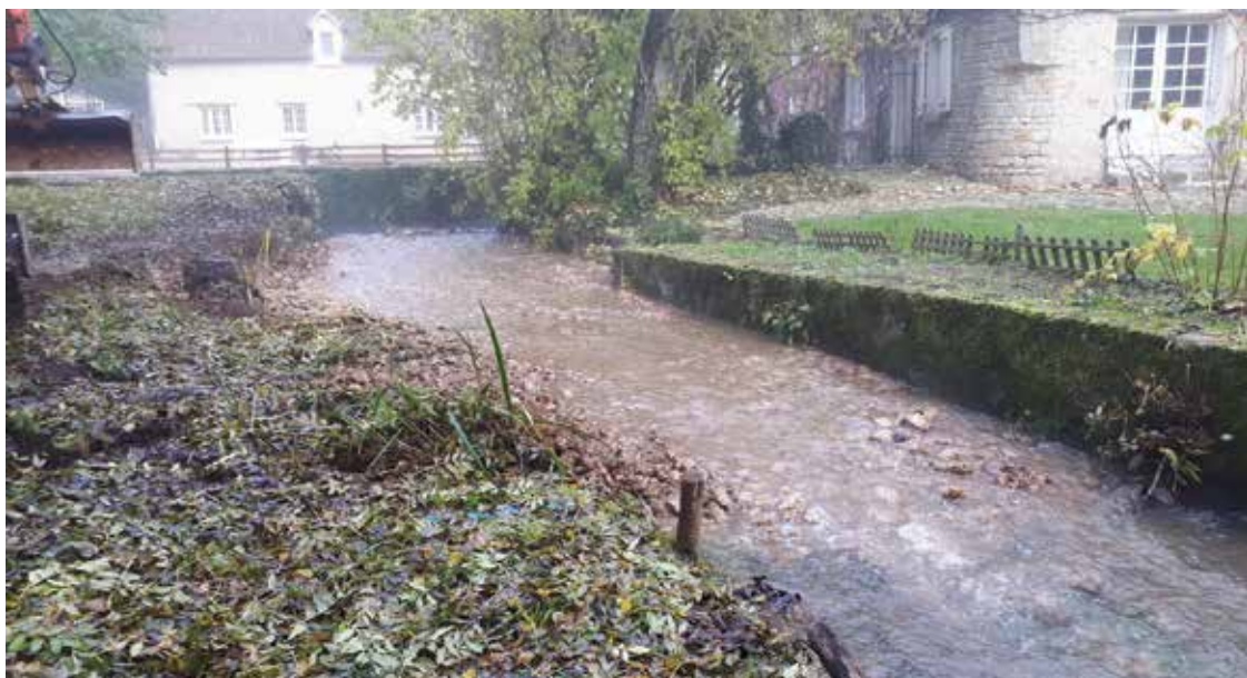
Ouvrage du moulin de Doureux (ROE86617) rendu franchissable par une rampe en enrochement
