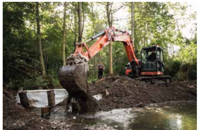
Création d'un batardeau sur le cours de l'Œuf pour remettre en eau l'ancien talweg
