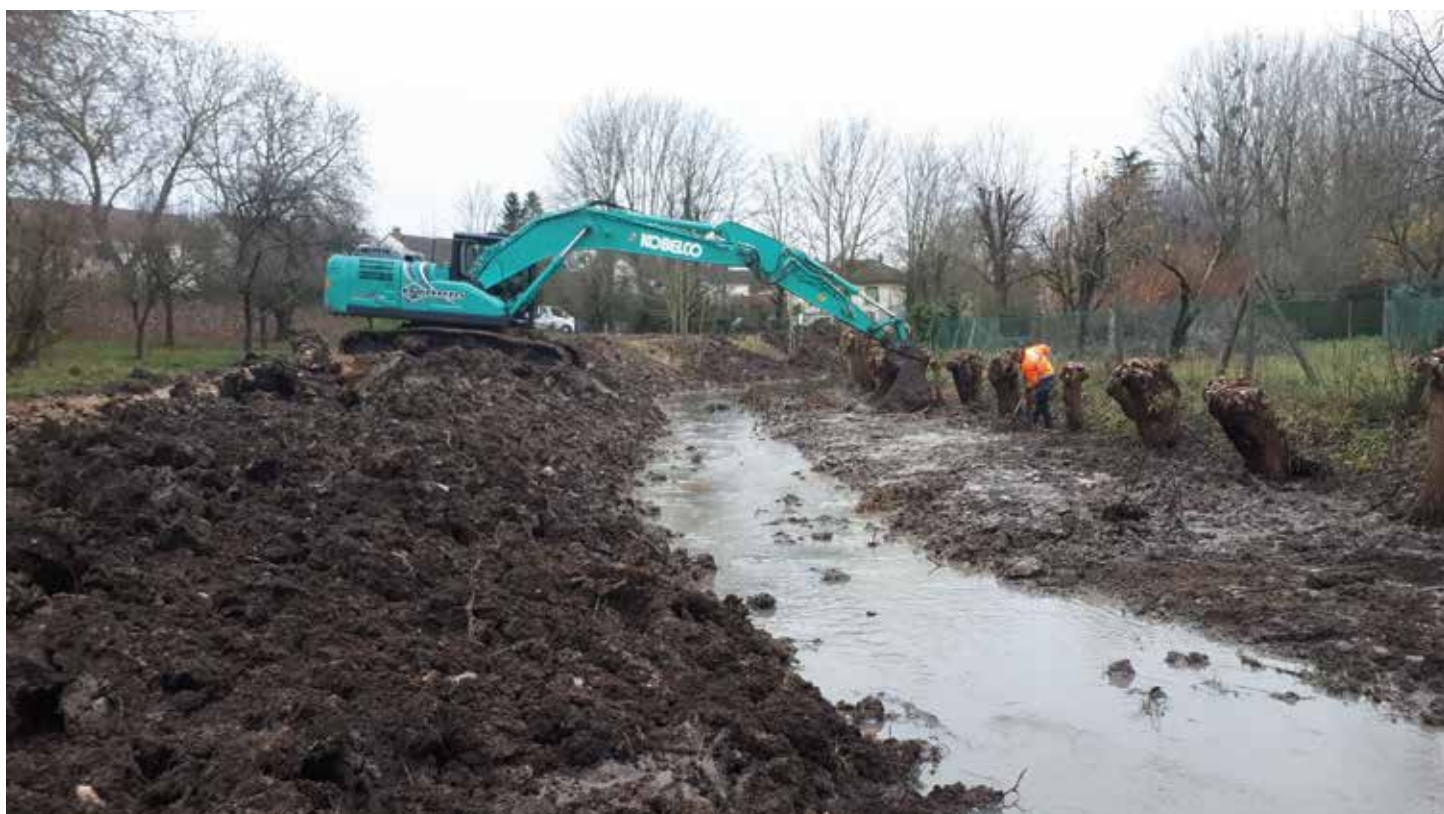
Création de banquettes par talutage des berges
