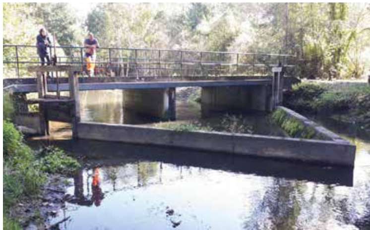
Seuil en V infranchissable (ROE46038) avant travaux
