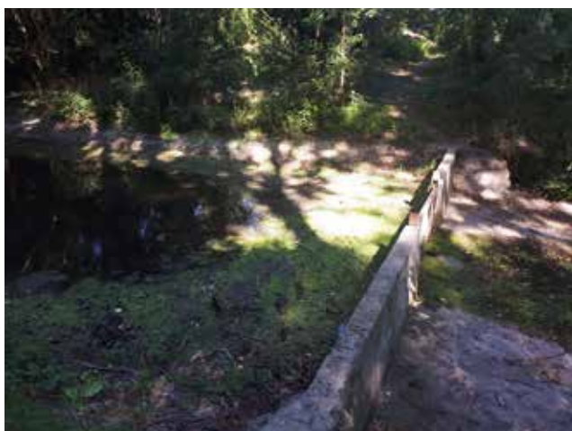
Ouvrage du bourg (ROE46029) avant travaux
