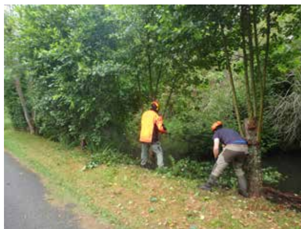
Entretien en régie régulier de la végétation (taille en têtard) sur la noue de Doureux
