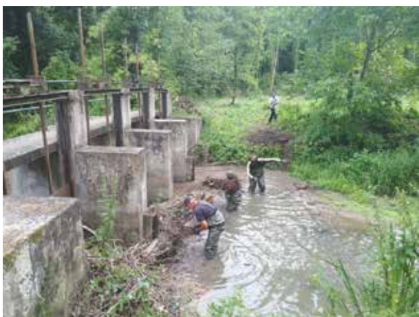
Enlèvement d'embâcle sur l'ouvrage de Yèvre la Ville avec ASER
