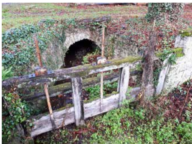
Ouvrage latéral rendu franchissable (ROE86618) - avant travaux
