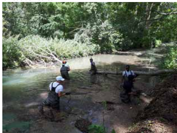
Enlèvement d'un arbre en travers du cours avec ASER
